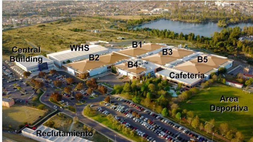
Figura 2: Vista Panorámica de Sensata Technologies México
